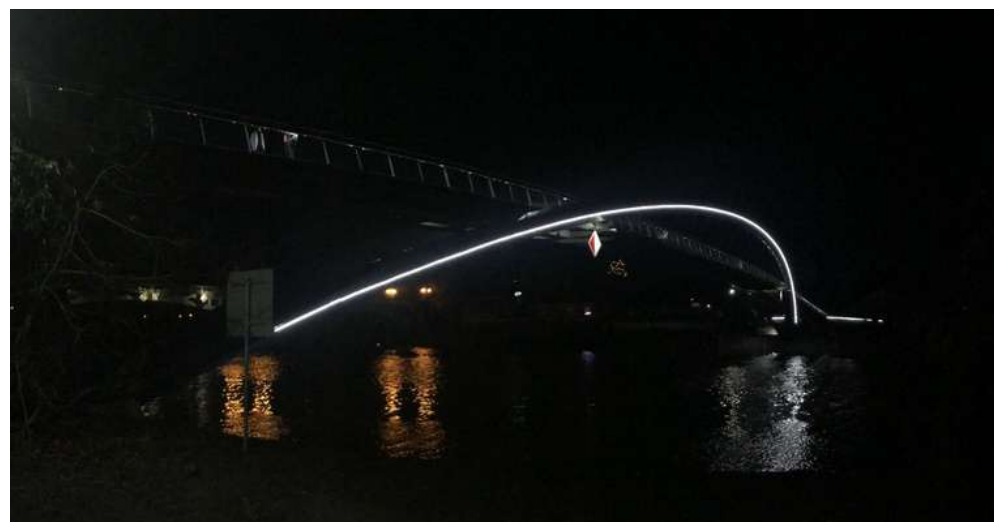
Osvětlení lávky přes Labe, Poděbrady
